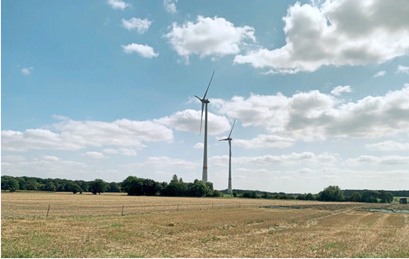
In der Bauerschaft Aldenhövel stehen seit Längerem bereits Windräder.
