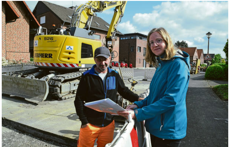
Manuela Baltrusch aus der städtischen Bauabteilung und Vorarbeiter Eugen Ochorowski von der Baufirma Steinbrecher aus Rheine tauschen sich über den Stand der Sanierungsarbeiten an der Stadtfeldstraße aus.
