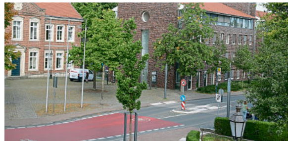
Bisher endet die rote Fahrbahn vor der Borg. Das soll sich noch in diesem Jahr ändern, denn die Verwaltung strebt an, dass die Umsetzung im Rat am 15. September beschlossen wird. Foto: acf
