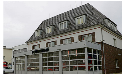
Auf dem Dach des Feuerwehrhauses möchte die „LH-BürgerEnergie eG“ eine Photovoltaikanlage installieren, ebenso auf der Flüchtlingsunterkunft am Rohrkamp 6. Der Ausschuss für Umwelt, Bauerschaften, Klima und Mobilität hat jetzt beide Vorhaben abgesegnet. Foto: awi
